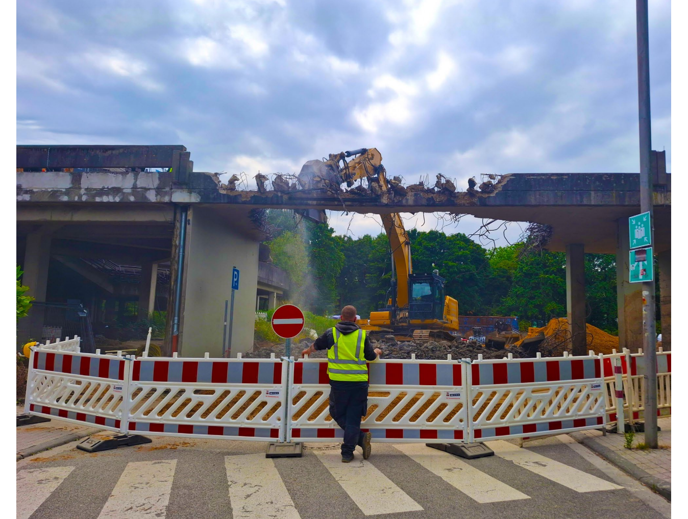
Abb. 1: beispielhafter Rückbau eines Stahlbetonbauteils
