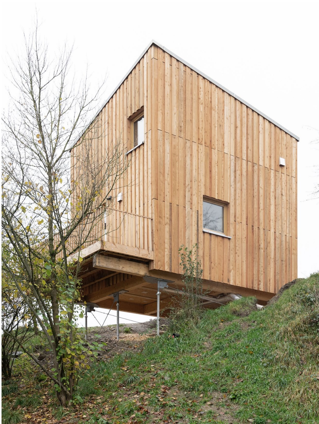
Bild 2: Außenansicht Forschungsdemonstrator M1 zum Zirkulären Bauen am Standort :metabolon in Lindlar. Foto: Felix Beuter
